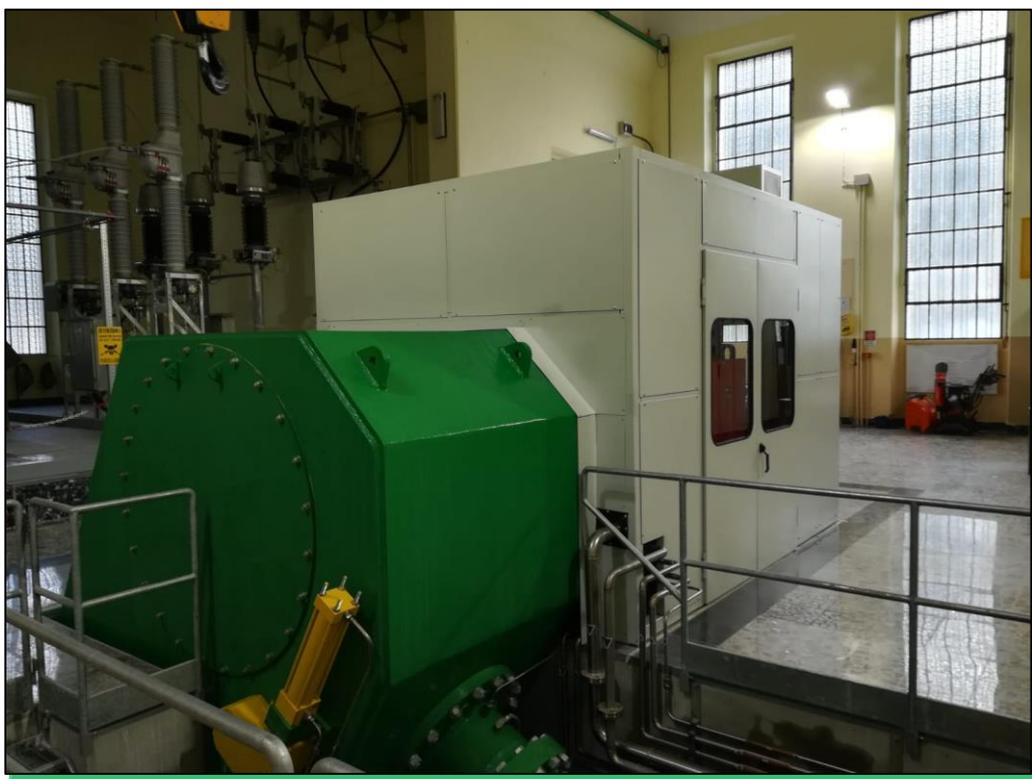
**Foto 22** – Sistema di insonorizzazione della sala macchine della centrale di Ponte Acqua (BG)
